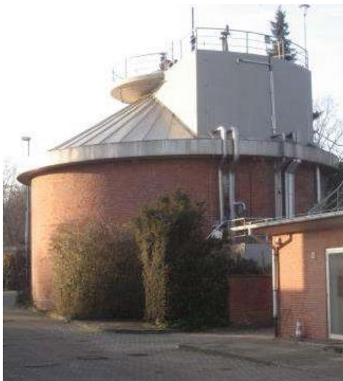
Abbildung 1: Faulurm Kläranlage Trittau
