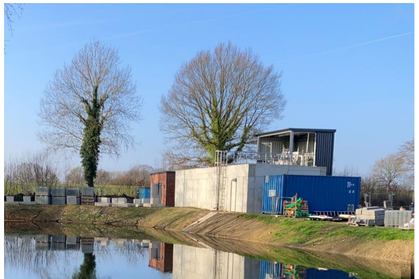
Abbildung 2: Neubau der technischen Kläranlage Grabau (Bauphase)
