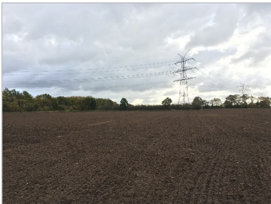
Abb. 6: Hochspannungsstrommast im Plangebiet
