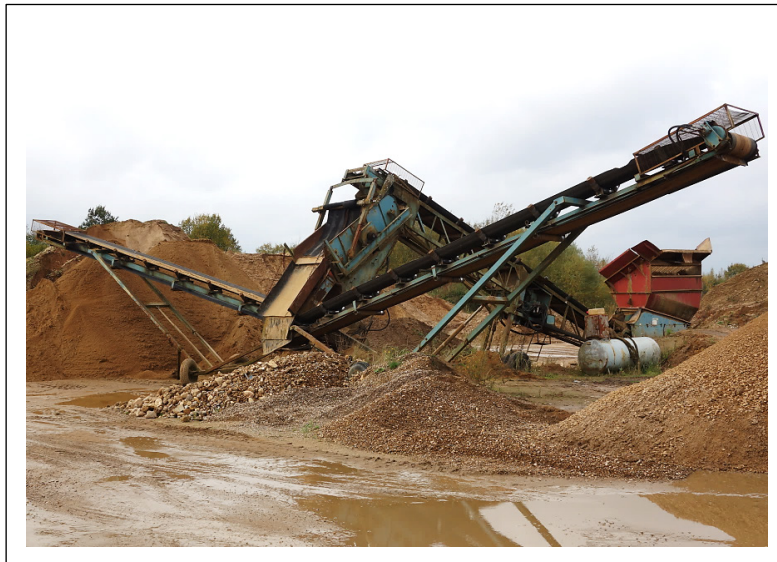
Siebanlage mit Dieselantrieb (Schallquelle 4)
