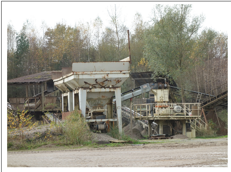
Stationäre Natursteine- Brecheranlage (Schallquelle 1)
